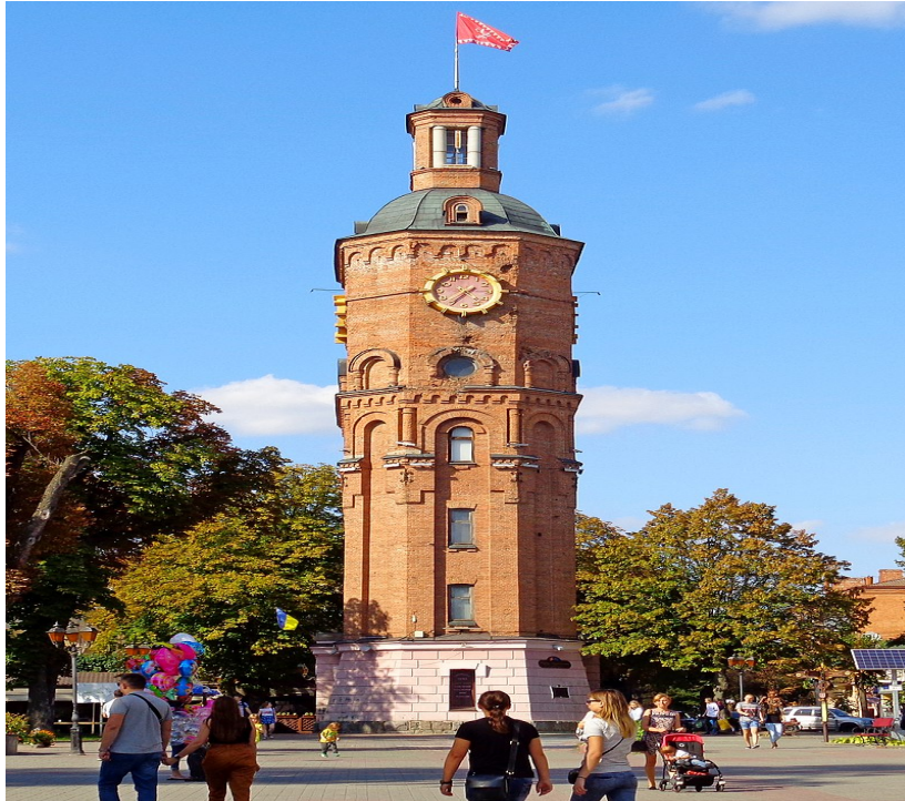
Рис.1. Вінницька водонапірна башта.
