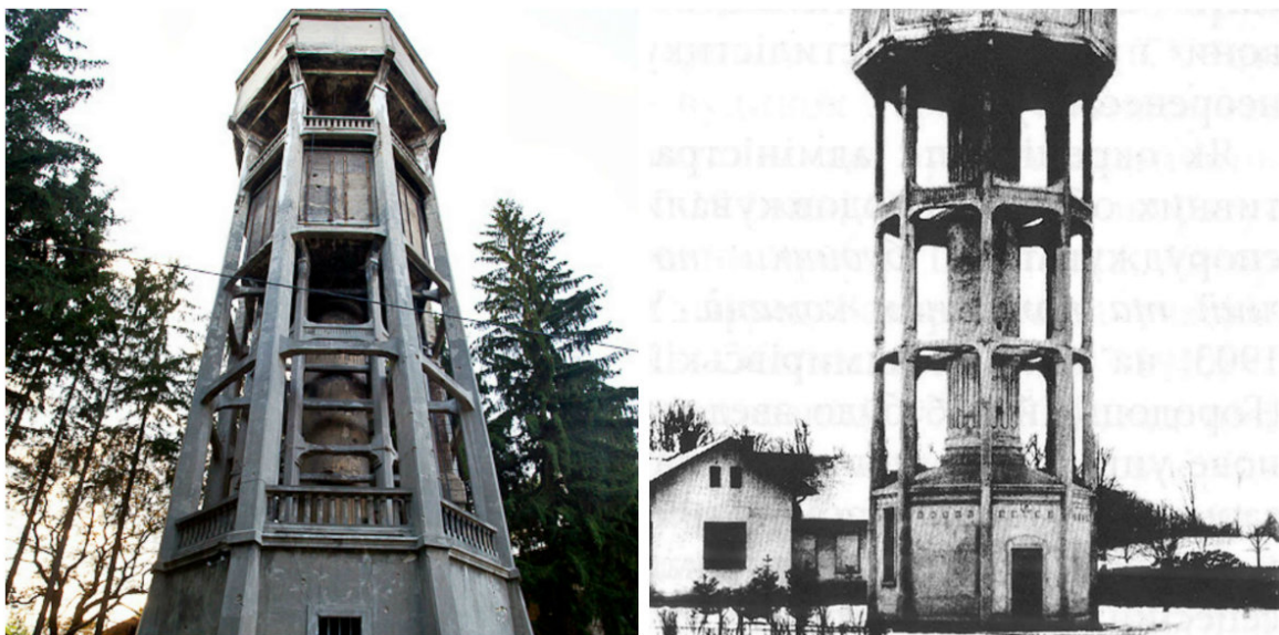
Рис.6. Водонапірна башта на Кульпарковій: ліворуч - сучасний вигляд, праворуч - початковий варіант, до реконструкції 1930 року.
