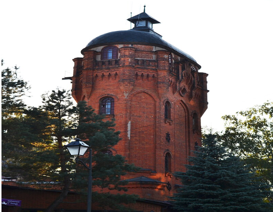
Рис.2. Водонапірна башня, м. Житомир.
