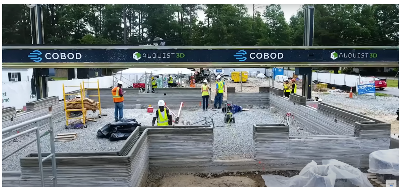
Рис. 1. Будівельний майданчик з 3D-друку житлової будівлі
