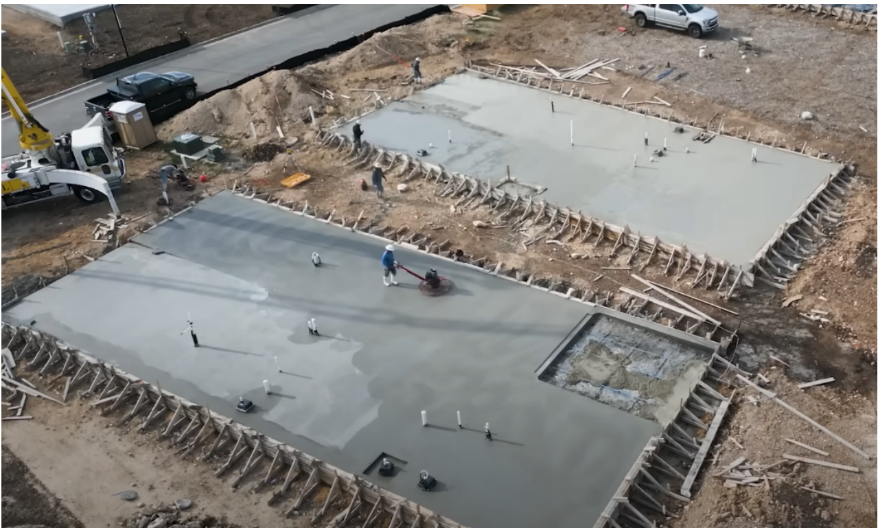
Рис. 2. Підготовка та моніторинг основи під 3D-будівництво
