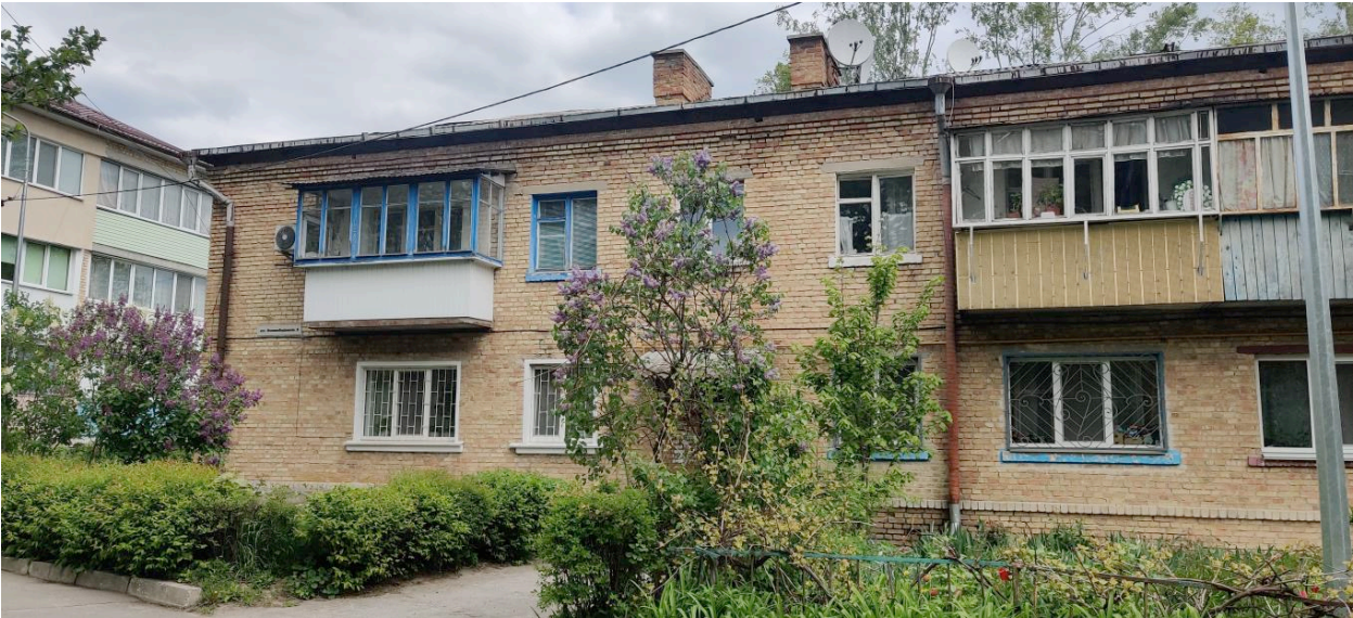
Рис. 1. Загальний вигляд житлового будинку по вул. Машинобудівників, 8 в смт. Чабани, Фастівського району, Київської області.
