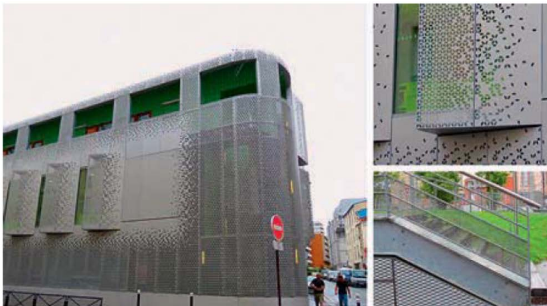
Рис. 6. Типи перфорації: наскрізне пробивання, просічне видавлювання (Париж, Ліль, Франція).
