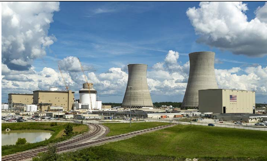
Рис. 3. Атомна електростанція Vogtle 3 і 4 в США [17]
