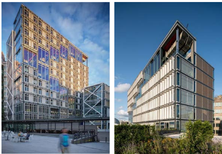
Рис. 9. Зовнішній вигляд LSE Centre Building
