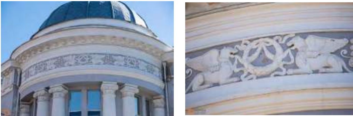
Рис. 9. Деталі кутової частини фасадів будинку Д. Харлаба по вул. Театральній 17/7 (фото автора)
