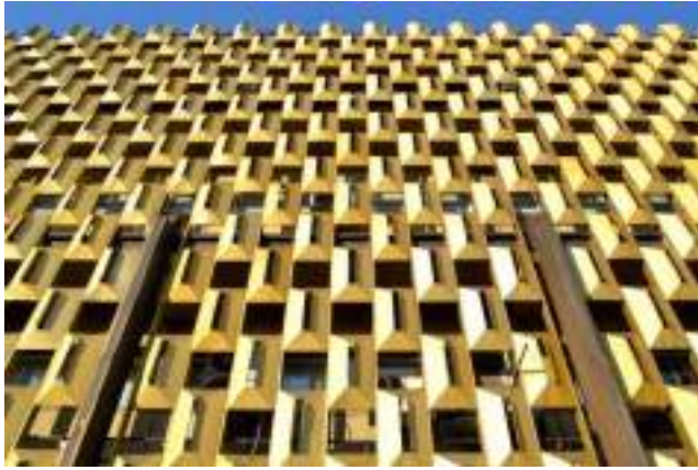
Алюмінієвий brise-soleil на фасаді універмагу «Дитячий світ» (1974–1987) у Києві. Арх. В. Залуцький, Ю. Бородкін [7]
