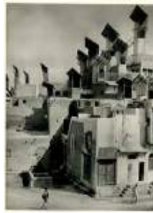
Рис. 11. Вітровловлювачі або вітряні вежі, також звані бараджил (одн. barjeel ), малакіф (одн. milqaf ) і бадгір : Восьмигранний Бадгір (Язд, Іран), двосторонній бараджил (Манама, Бахрейн) [33], вітряні вежі в інтер'єрі східного міста, Іран [33]
