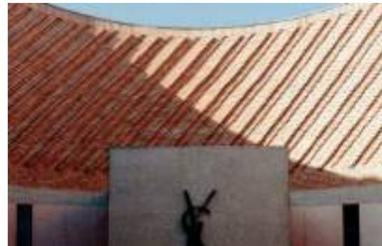
Музей Іва Сен-Лорана в Марракеш, Марокко [27]. Стіни музею складається з двох шарів: фасад покритий панелями терацо навколо основи, з теракотовою цеглою на верхньому рівні. Ці цеглини розташовані таким чином, що відкидають тінь і роблять фасад ще більш тактильним, нагадуючи тканину
