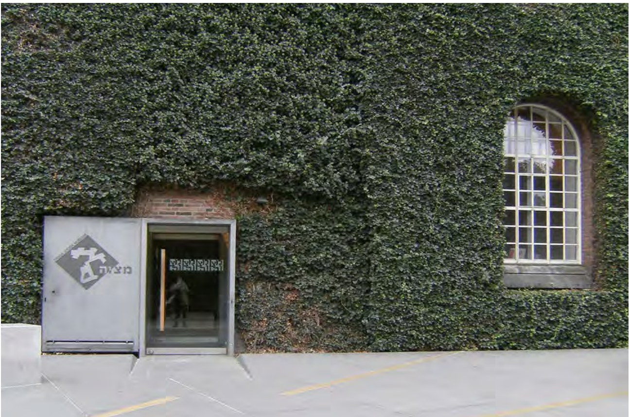
Рис. 2. Прямий зелений фасад, Голеган, Португалія.
