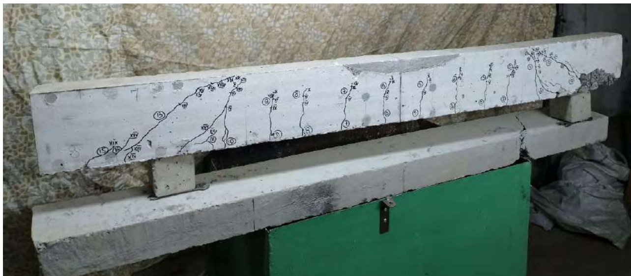
Рис. 4. Утворення тріщин у пошкодженій балці
