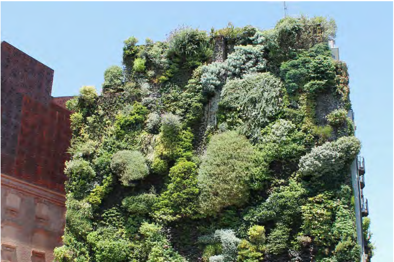
Рис. 3. Суцільна система живих стін, Caixa Forum, Мадрид.
