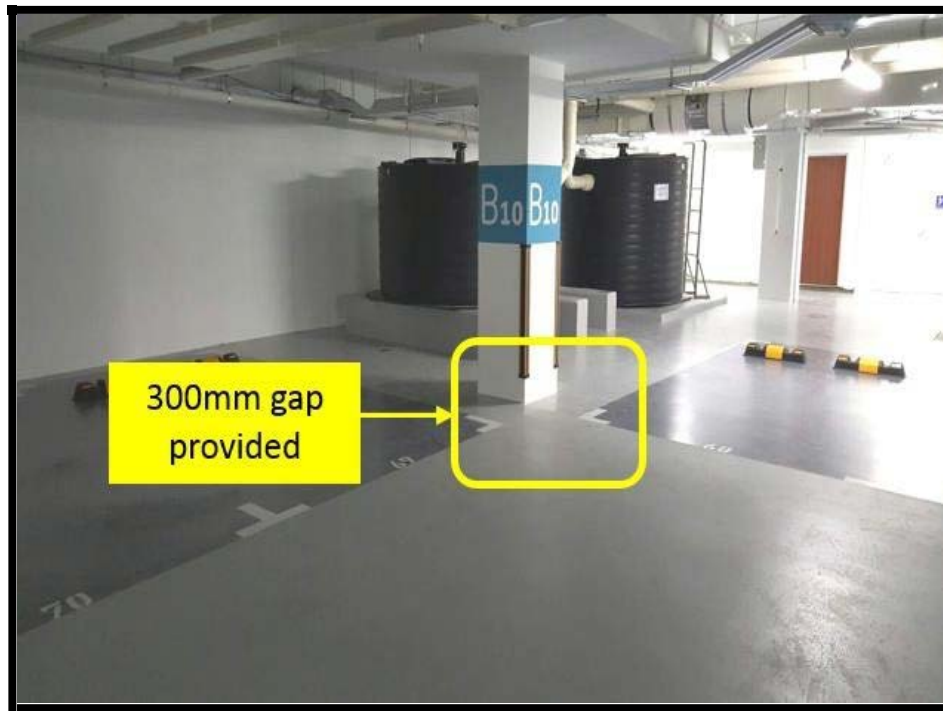
Рис. 6. Приклад збільшення ширини перпендикулярних паркомісць біля колони у гаражах (Сінгапур)
