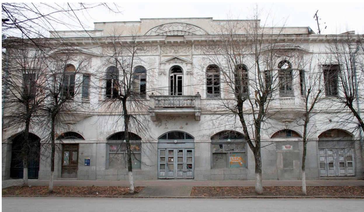
Рис. 4. Фасад будинку по вул. Театральній, 10 ( фото автора)
