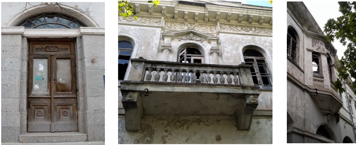
Рис. 5. Деталі фасаду по вул. Театральна, 10: 1. – ліві входні двері (автентичні); 2. - балкон ; 3. - еркер; (фото автора)
