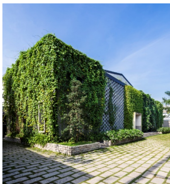
Реконструкція фабрики Desino з виробництва одягу та аксесуарів, Бінь Чань, Хошимін, В'єтнам, 2015. Озеленення фасадів будівлі створює захист від перегріву приміщень та комфортні умови праці [28]
