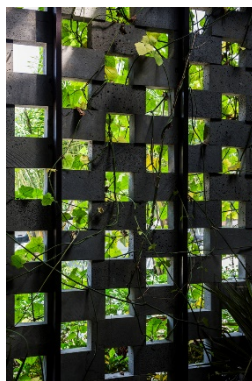
Реконструкція фабрики Desino з виробництва одягу та аксесуарів, Бінь Чань, Хошимін, В'єтнам, 2015. Озеленення фасадів будівлі створює захист від перегріву приміщень та комфортні умови праці [28]
