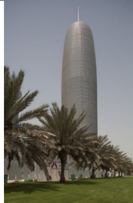
Вежа Доха у Досі, Катар, 2012 рік, архітектор Жан Нувель. Фасад будівлі покритий металевим бриз солейм на основі візерунку традиційної арабської машрабії [29]
