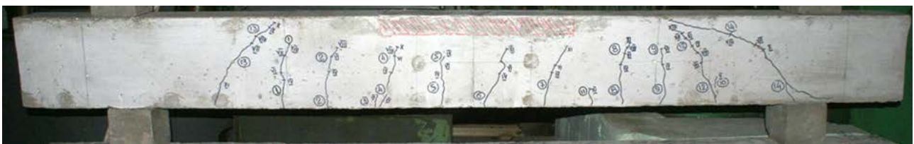
Рис. 6. Утворення тріщин у пошкодженій балці
