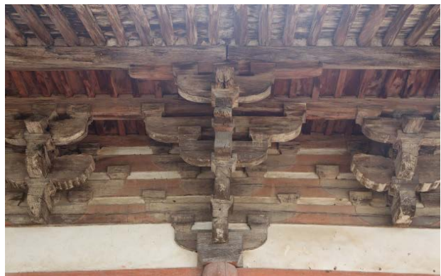
Рис. 6. Фрагмент конструкції храму (фото О. Ітсушін)
