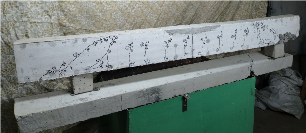
Рис. 4. Утворення тріщин у пошкодженій балці
